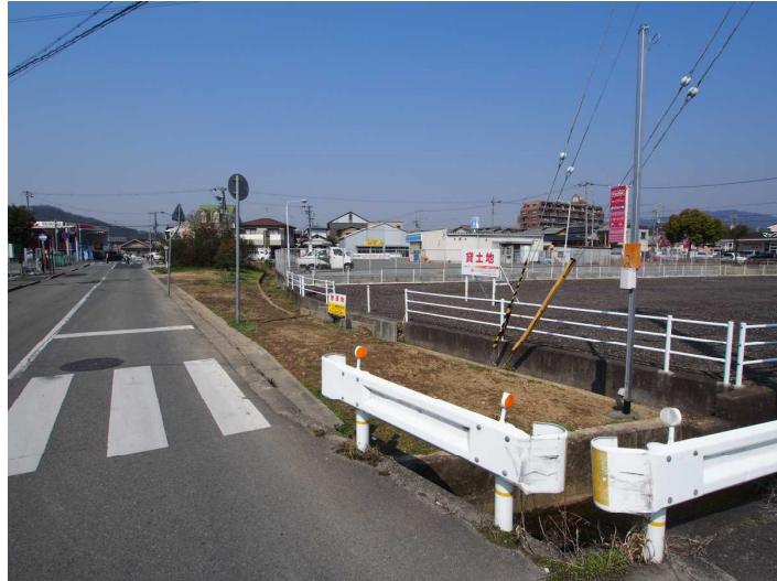
南東側より撮影
